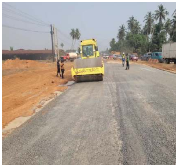
Travaux de la chaussée de l'ancienne route de Bassam
