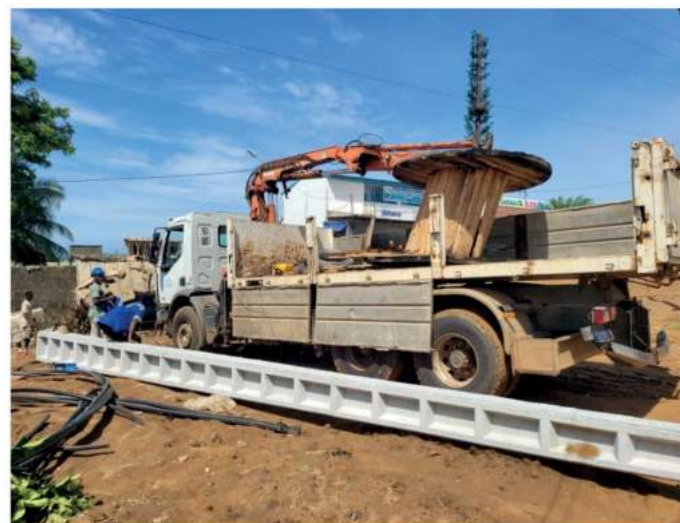
Travaux de raccordement du site au réseau MT aérien existant au départ de Dabou
