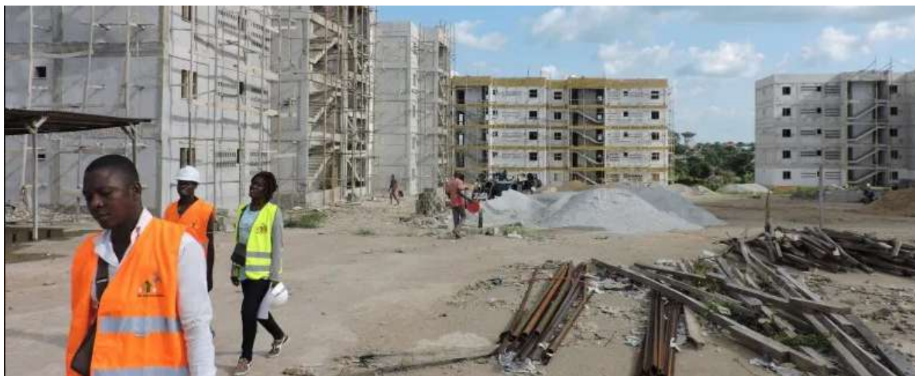
Vue d'un chantier en construction
