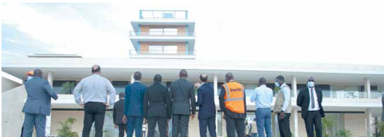
et extension du bâtiment principal des annexes, de la piscine et des aménagements extérieurs.
