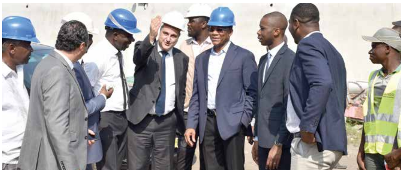
Visite Chantier Addoha en compagnie de ses responsables locaux
